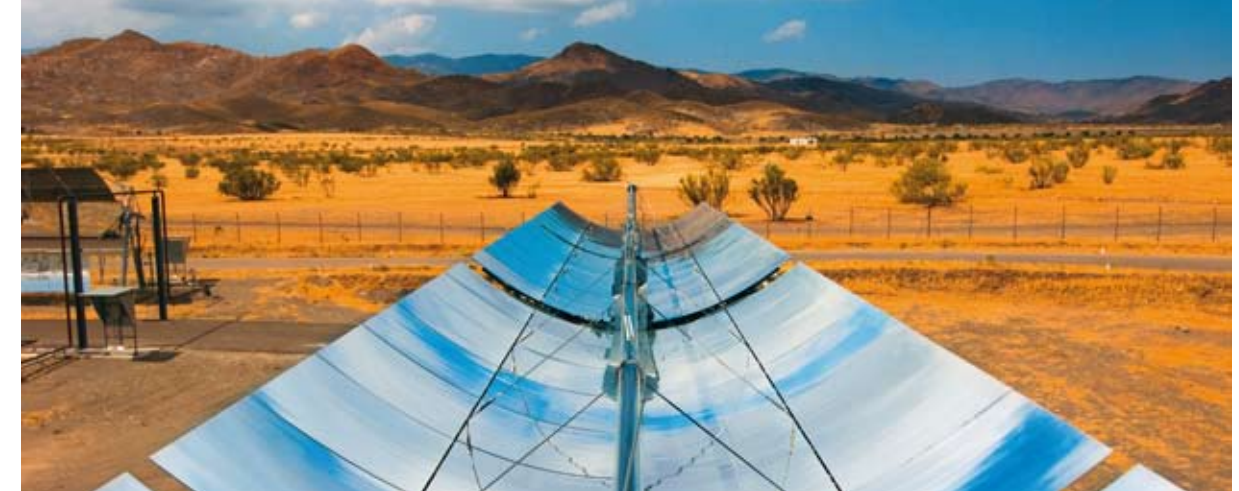
Standorte mit hoher Sonneneinstrahlung sind ideal für Solar-kraftwerke.
