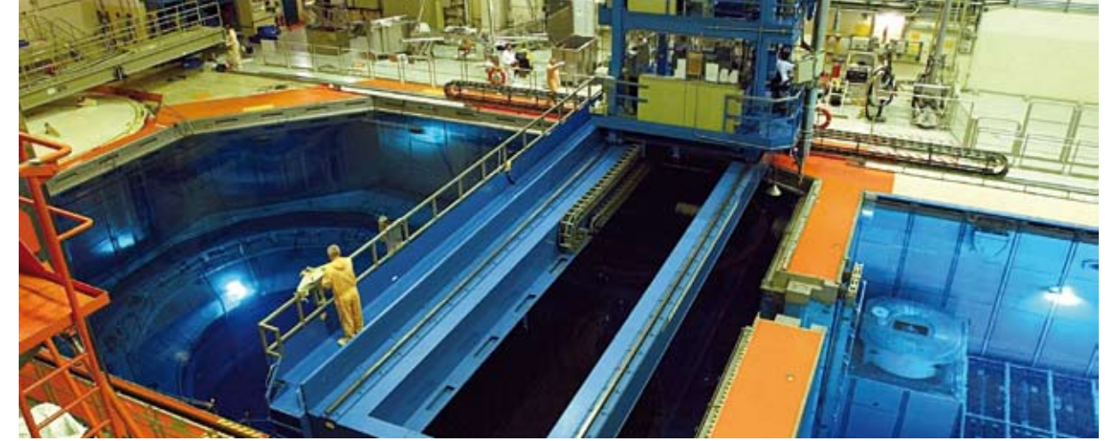
Abklingbecken eines Kernkraftwerks.
