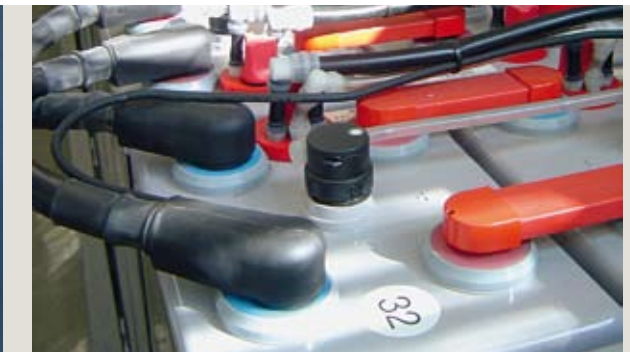
Speichertechnik Neue Reserven für Stromnetze
