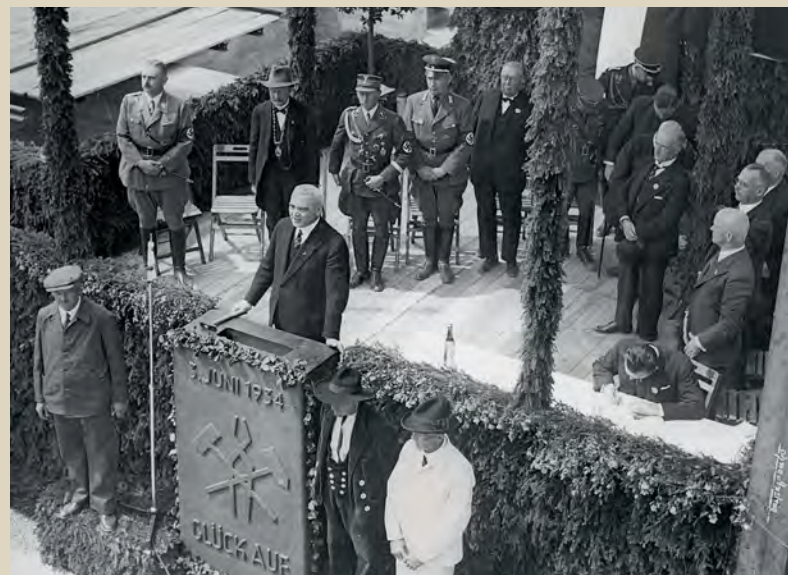
Grundsteinlegung: Albert Vögler, Vertreter der Stahlindustrie und späterer Präsident der Kaiser-Wilhelm-Gesellschaft, bei seiner Rede auf der Feier am 3. Juni 1934 in Düsseldorf.
