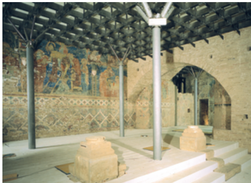
Blick in die freigelegte Unterkirche des Doms mit ihrem Freskenschmuck von etwa 1280. Der darüber gelegene Chor der Kirche wird von einem modernen Stützensystem getragen.
