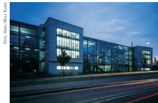
Räume für 200 Mitarbeiter bieten die neuen Gebäude des Max-Planck-Instituts für Dynamik komplexer technischer Systeme in Magdeburg.
